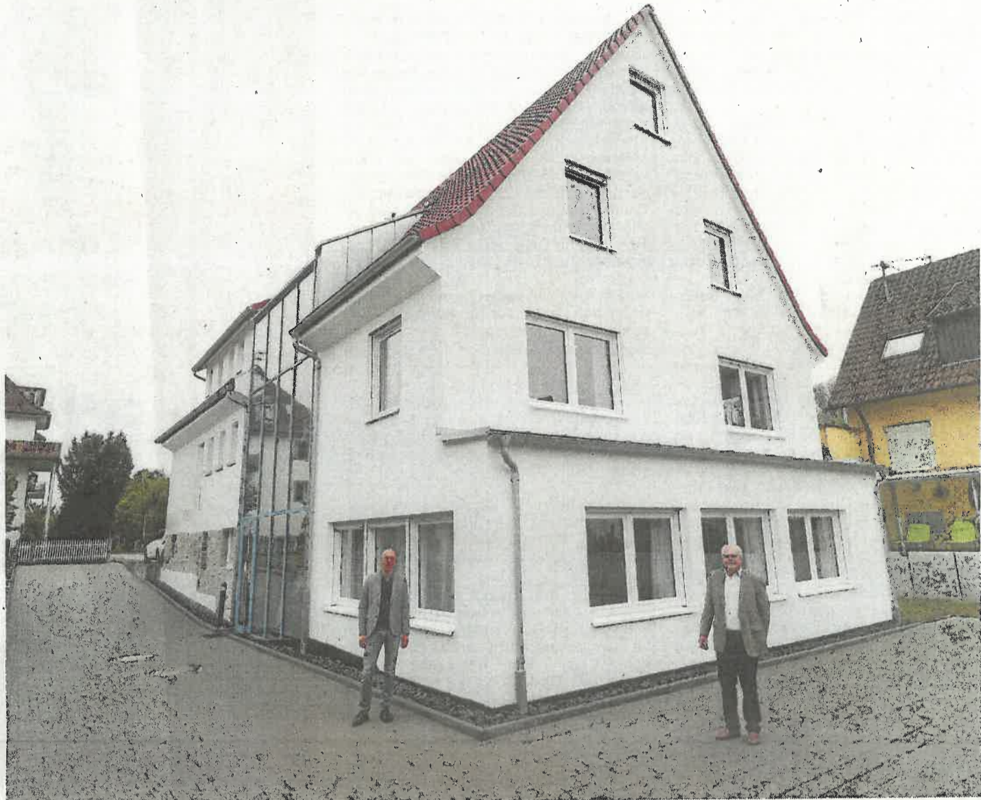
Thomas Nehr und Werner Stingel (von links) vor der neuen schmunken Diakonie ambulant. Der Neubau (vorne) ist über das Treppenhaus sowie eine Wärmeschutzglasfassade mit dem Altbau weiter hinten verbunden. Fotos: J. Fiedler
